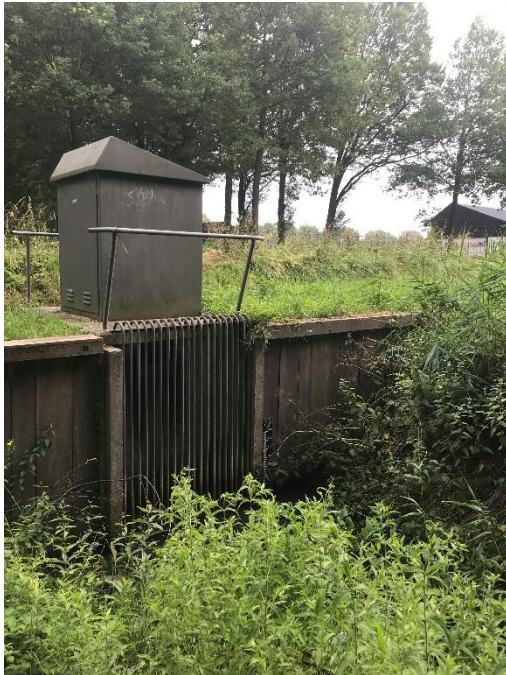
Foto 4: Gemaal in A-watergang ZL22 aan de zuidzijde van de Leemputten. Dit gemaal heeft een aanslagpeil van 7,60 m. +NAP. Rechts: Leggerkaart Waterschap de Dommel. Hierop is te zien dat het uitgedempte water in A-watergang ZL-20 stroomt, welke het water ten zuiden van Leemkuilen in noordoostelijke richting afvoert. Het waterpeil van watergang ZL-20 wordt hier bepaald door de bodemhoogte van de duiker onder de Haarense baan van 8,14 m. +NAP. Voor een overzichtkaart van de A-watergangen wordt verwezen naar Bijlage 1.
