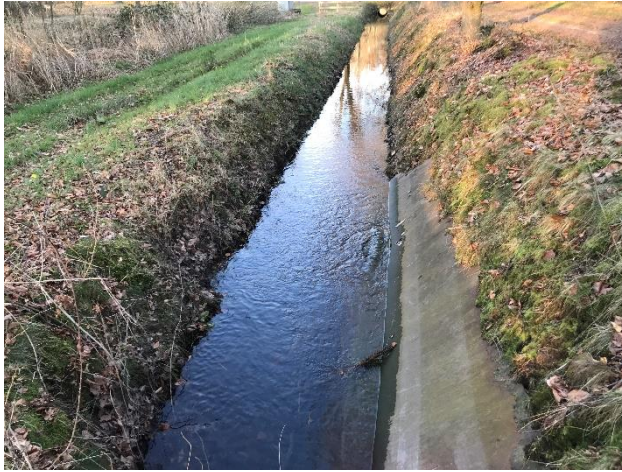
Foto 6: Uitstroming via onder water gelegen verbindingsduiker DSH0008041 tussen de waterwinplas Brabantse hoek en A-watergang ZL-24 (klein traject), die het water in noordoostelijke richting afvoert naar de ZL-20 (Waterschap De Dommel, 2025). De A-watergang wordt tevens vanuit de noordwestzijde via een gemaal wordt gevoed door A-watergang ZL-23, die de afwatering van de gronden ten noorden en noordwesten van de Leemkuilen verzorgt. A-watergang ZL-20 wordt tevens vanuit het zuidoosten gevoed door bovenlopen van watergang ZL-20 die de afwatering van de gronden ten zuiden van de Leemkuilen verzorgt. Voor een overzicht van de leggerwatergangen wordt verwezen naar de overzichtkaart in Bijlage 1.
