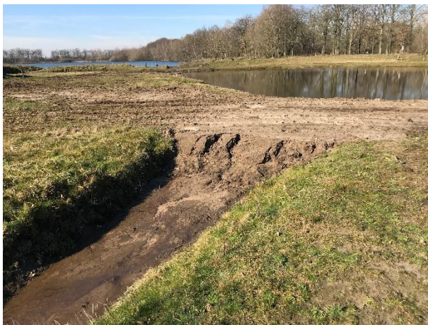
Foto 8: Links: deels herstelde drempelhoogte van de Heidekreitenplas door het aanbrengen van een grondwal in de verbindingssloot tussen poel H1 en A-watergang ZL-22. Rechts: 2e grondwal in de verbindingssloot tussen de Heidekreitenplas en poel H1. Het water stroomde tijdens het veldbezoek in maart 2022 uit de Heidekreitenplas over maaiveld naar poel H1. Hierdoor werd het waterpeil van de Heidekreitenplas afgetopt op 8,4 m. +NAP.
