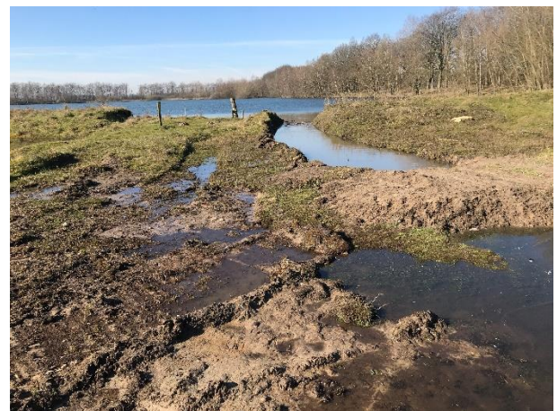
Foto 8: Links: deels herstelde drempelhoogte van de Heidekreitenplas door het aanbrengen van een grondwal in de verbindingssloot tussen poel H1 en A-watergang ZL-22. Rechts: 2e grondwal in de verbindingssloot tussen de Heidekreitenplas en poel H1. Het water stroomde tijdens het veldbezoek in maart 2022 uit de Heidekreitenplas over maaiveld naar poel H1. Hierdoor werd het waterpeil van de Heidekreitenplas afgetopt op 8,4 m. +NAP.
