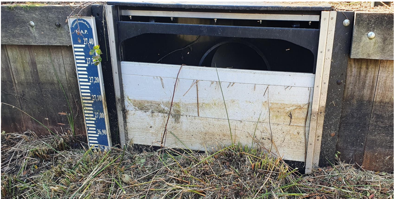
Figuur 4-14: Peilschaal bij stuw 2 (BU02_O) in De Bult
