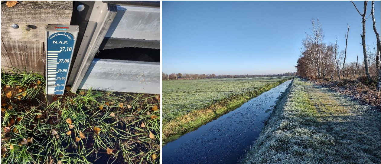
Figuur 4-15: Links Stuw 3 (BU03_O) aan de noordwestzijde van De Bult. Dit compartiment watert af bovenstrooms van een stuw in de Kaweische Loop. Rechts de Kaweische Loop grenzend aan De Bult.
