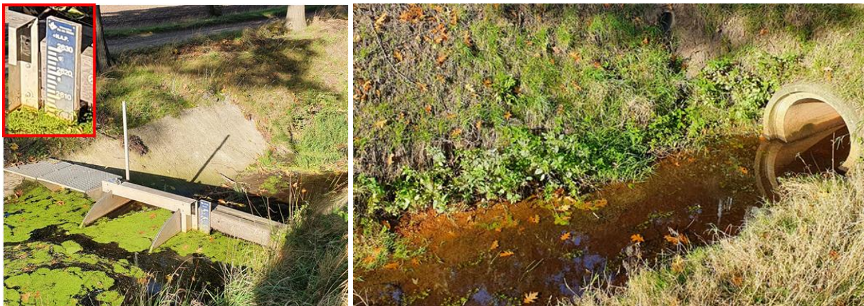
Figuur 4-12 Links: stuw in Peelloop bij noordwesthoek De Bult. Peil in oktober 2022 rond 26.0 m NAP. Circa 1 meter verval over stuw. Rechts: ijzerrijk grondwater benedenstrooms van stuw in Peelloop bij kruising met Goorsebergweg.
